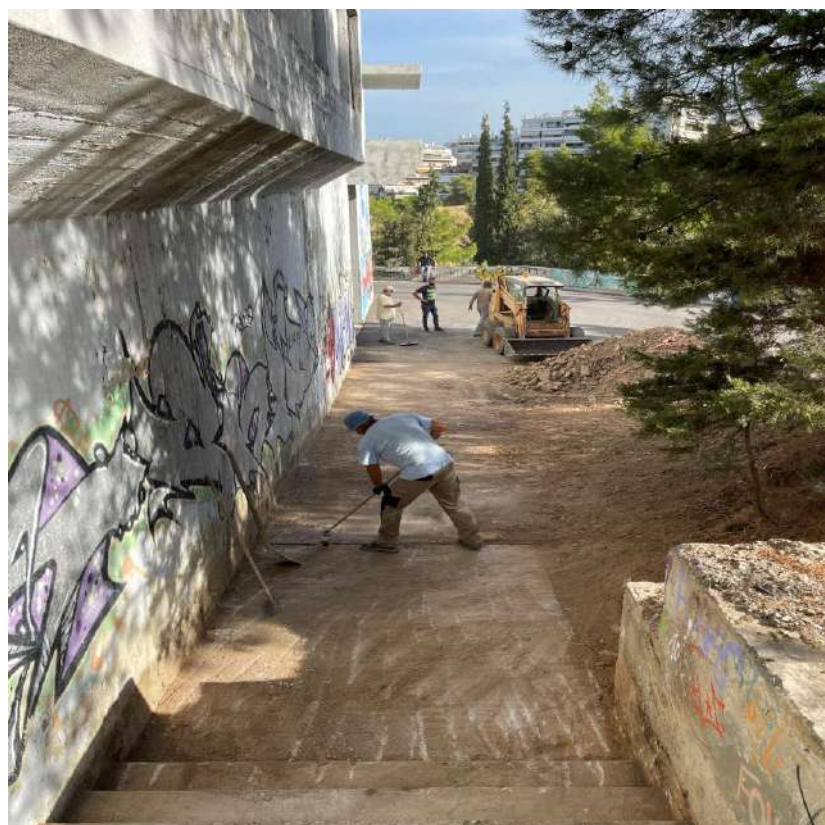
Αποκατάσταση της κάτω εισόδου του αμφιθεάτρου.
