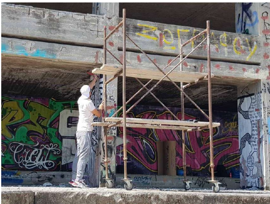
Αποκατάσταση του φθαρμένου από το χρόνο σκυροδέματος.
