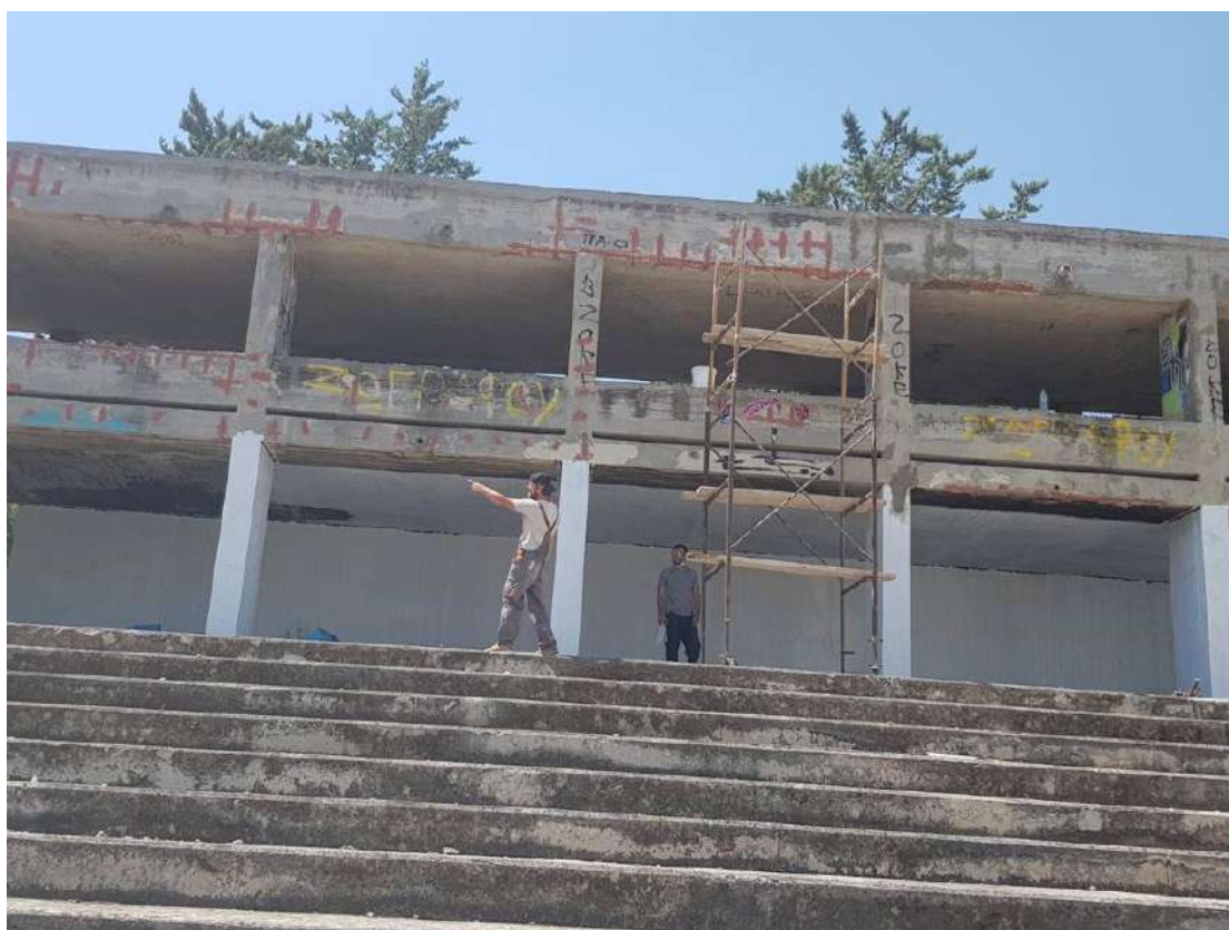
Έναρξη των εργασιών ανακαίνισης.
